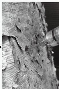
\* : 注入用針を注入穴底付近まで挿入し、薬剤を注入。静かに針を引き抜き、注入完了。
