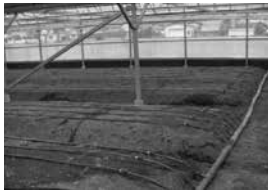
灌水チューブ配管
